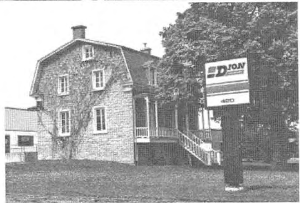
Dion Machineries occupe toujours l'emplacement de la ferme des fondateurs. La vieille maison familiale Dion veille toujours.
